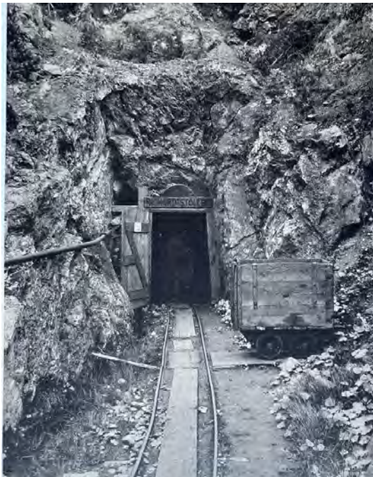
Abb. 1: Richard-Stollen am Trenning (Mühldorf) (Vor Versprengung bei Betriebsende)
