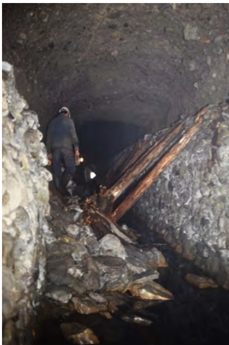
Abb. 3 Schaubergwerk Kupferplatte der GRANDER GmbH: Der vorderste Abschnitt des Heiligeist-Erbstollen noch vor dem Ausbau im „Urzustand“. Der Stollen steht in interglazialen, durch den Eisaufgedruck verfestigten Schottern. Der gebrochene, freie Firstverzug war zuerst wieder instand zu setzen. Vorderster Teil des Schaubergwerks. (Foto und Archiv Peter Gstrein, Innsbruck)
