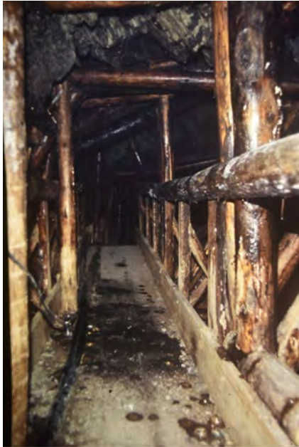
Abb. 5: Zillertaler Goldschaubergwerk: Der bereits vor dem Ausbau zum Besucherbergwerk gewältigte und neu ausgezimmerte Fahnenschlagstollen. (Foto und Archiv Peter Gstrein, Innsbruck)
