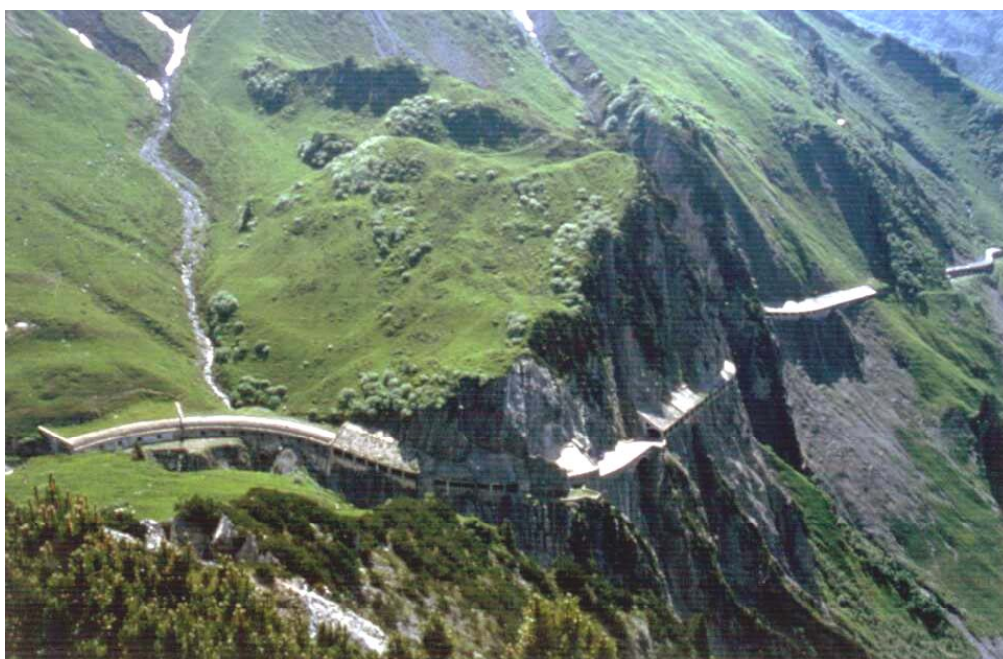
Abb. 3 Flexenstrasse (1897), Bauzustand 1999 (Foto BURGER)
